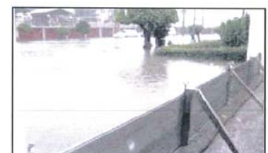
รูปที่ 11 : ระบบ STOP LOG (ภาพจากที่อื่น)
